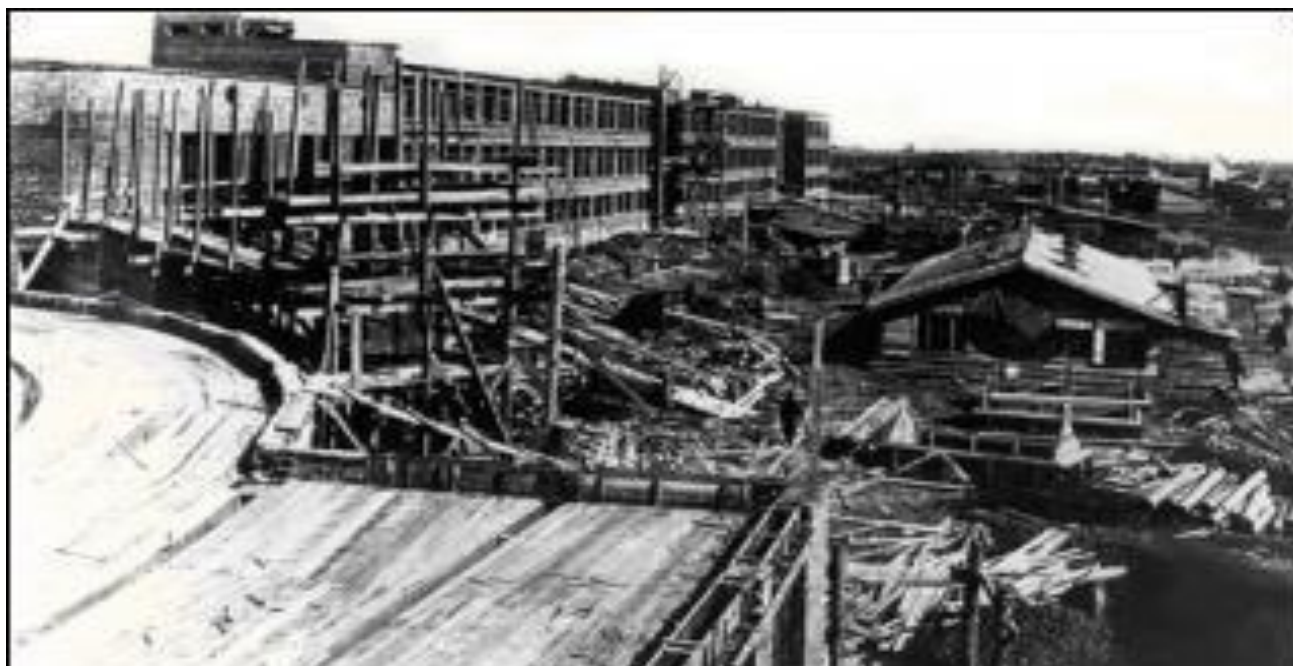
Рисунок 2.4. Строительство главного корпуса Барнаульского меланжевого комбината, 1933 г. [2]
